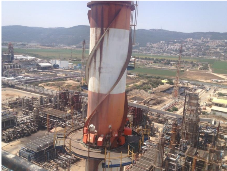
בתמונה: מיכשור לניטור רציף בארובת מה"ד סולר, בז"ן
